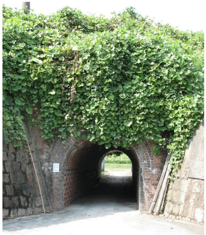
JR 山陽本線の梨ヶ原橋梁
